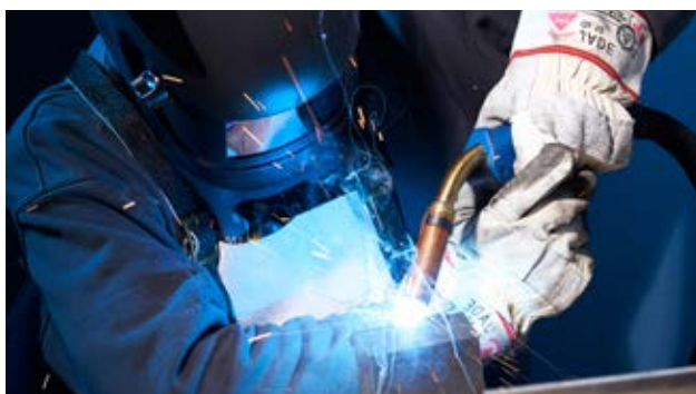
napawanie uszkodzonego narzędzia (metoda MAG)
